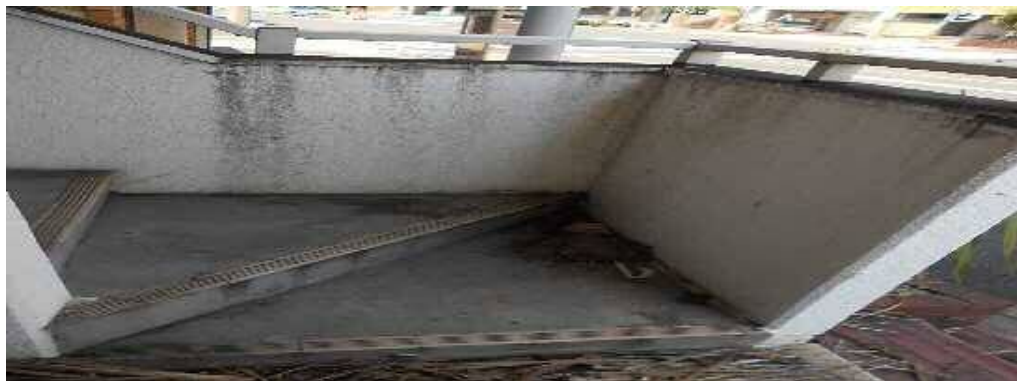
写真 ⑥(共用部分 1階から2階への階段)
