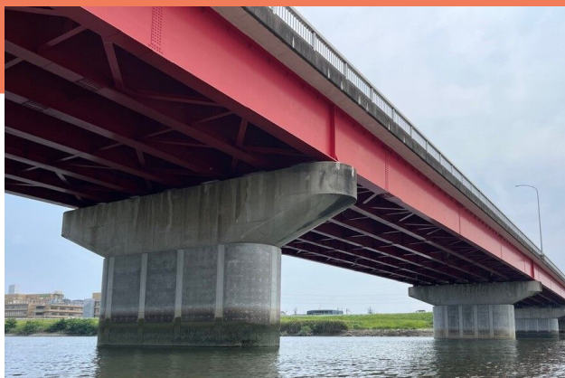
橋りょうの耐震補強
