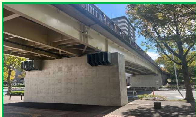
道路橋りょうの耐震補強
