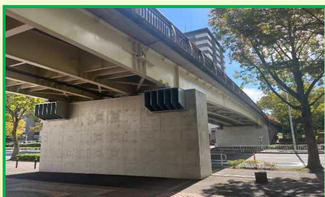
道路橋りょうの耐震補強
