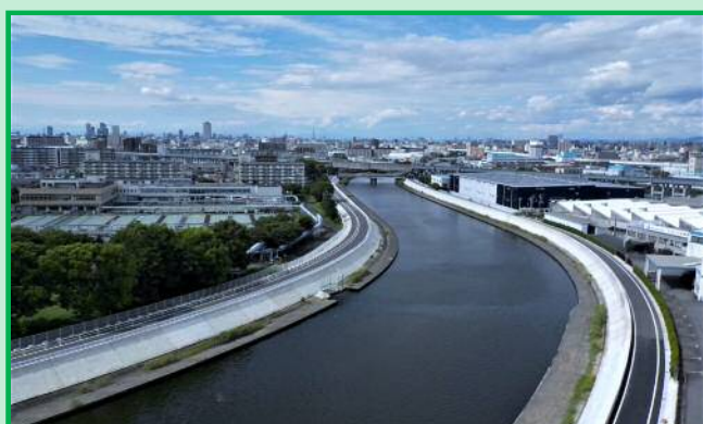
山崎川の堤防耐震補強
