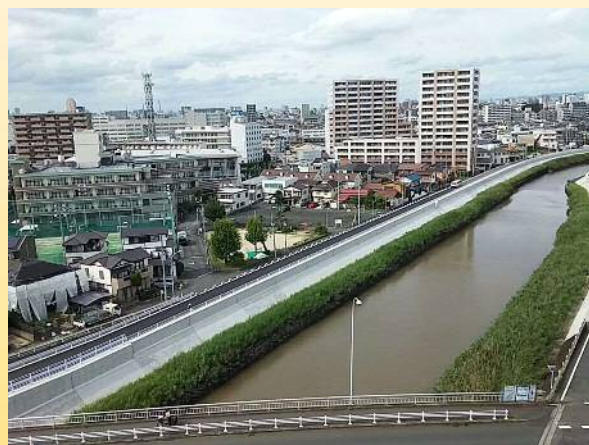
山崎川の堤防耐震補強
