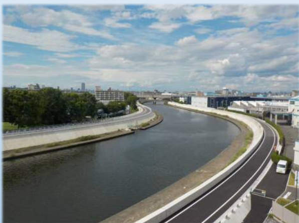
山崎川の堤防耐震補強
