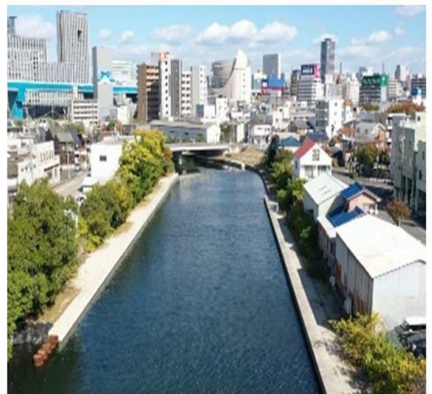
護岸整備状況
