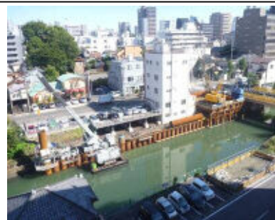
護岸改修と河道掘削
