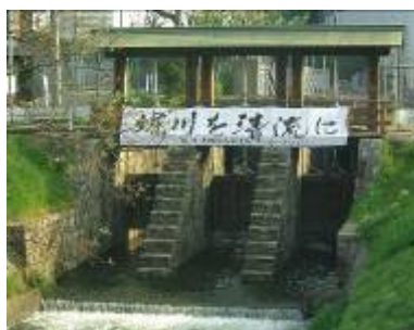
維持用水の確保 (庄内川からの導水)
