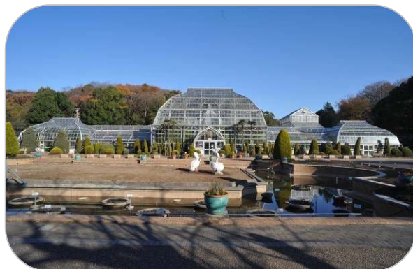
歴史文化的施設の保全・活用 重要文化財温室前館の保存修理
