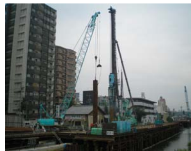
護岸改修と河道掘削
