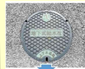
マンホール内部
