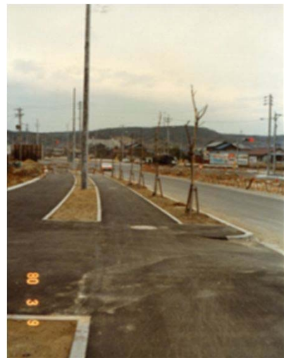
24 開通前の山手植田線 (昭和55年)
