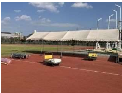
テント、ステージ、階段の足には全て コンパネ養生を行った
