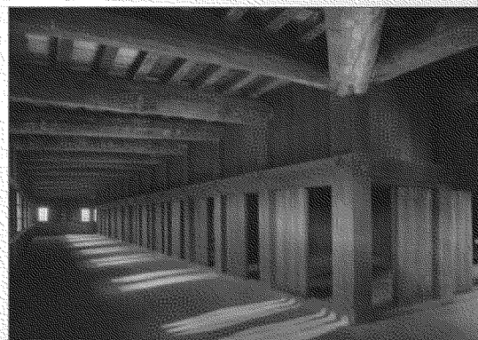
大天守1階西側入側（ガラス乾板写真） 9
