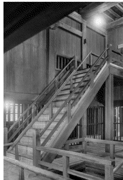
最上階の階段 (ガラス写真乾板)
