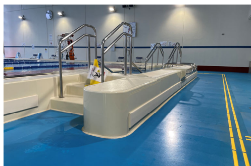
車いすから容易に入れる プールサイド
