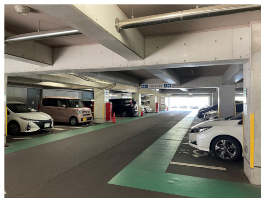
1階 屋内駐車場
