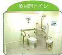
多目的トイレ
