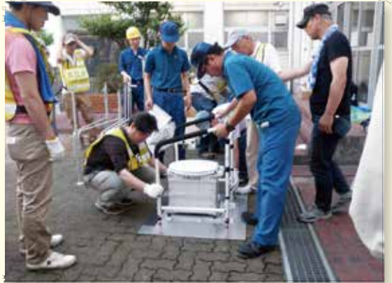
仮設トイレの組み立て
