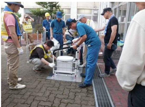
仮設トイレの組み立て
