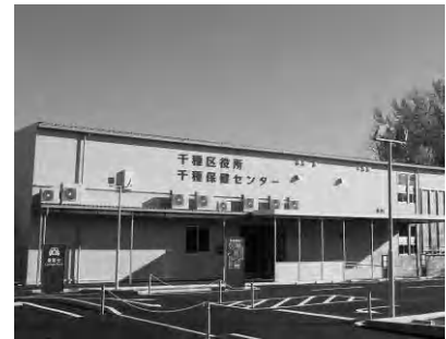
▲千種区役所仮設庁舎
