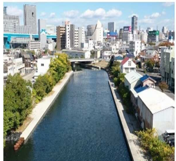
護岸整備状況
