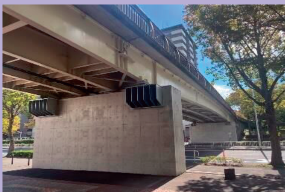
◆写真1 橋りょうの耐震化（三本松橋）
