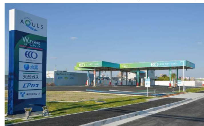
Estação de hidrogênio (Minato Aquils)
