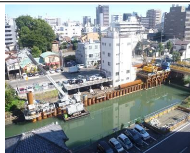
護岸改修と河道掘削
