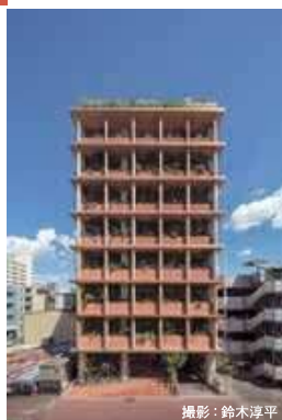
GOOD CYCLE BUILDING 001 浅沼組名古屋支店改修PJ
