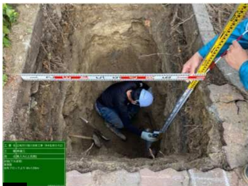
作業状況（深さ 2.1m）
