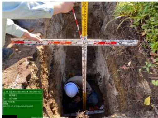
作業状況（深さ 1.9m）
