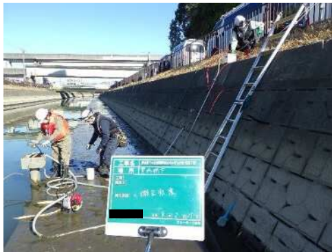
作業状況（河川側より撮影）
