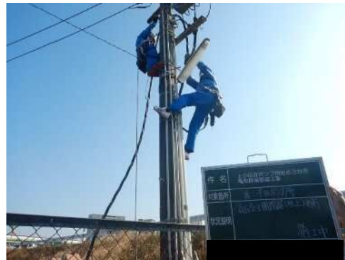
作業状況（高さ約 5.0m）
