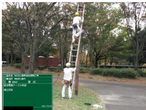
作業状況（高さ約3.5m）
