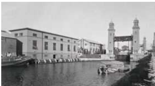
松重ポンプ所(左の建物)と松重閘門
