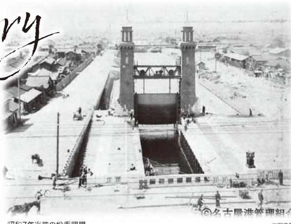
昭和7年当時の松重閘門
