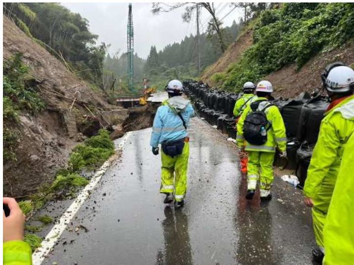
（中屋トンネル付近の様子）
