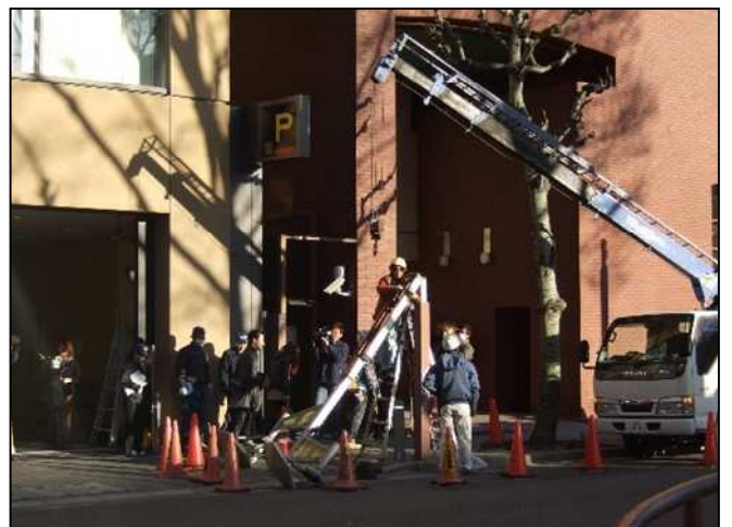
街路灯の倒壊事例
