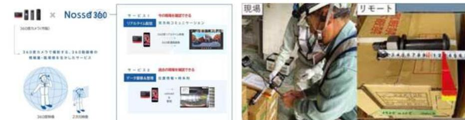
これまで現場訪問し対面で行われていた建設工事における段階確認、材料確認、立会といった臨場の業務を、360度カメラを使った現場と監督員のコミュニケーションツールを使用して、現場に行かずに遠隔で実施できるか検証を行った。
