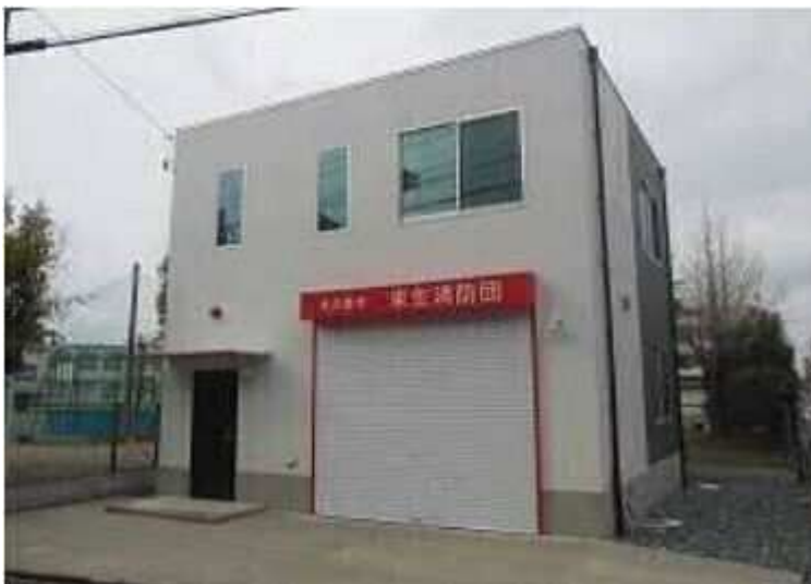
西区栄生消防団詰所
