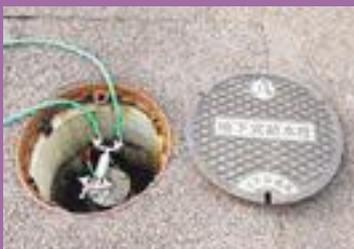
地下式給水栓（マンホールの蓋を開けると、中にじゃ口が設置されています。）
