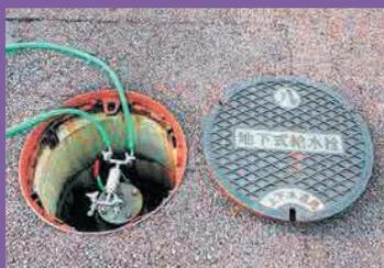
Hidrante subterrâneo (ao abrir a tampa de bueiro, encontra-se uma válvula no interior)
