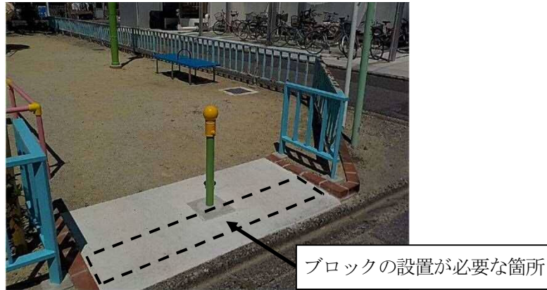
本件工事の状況
