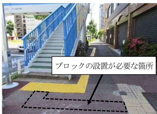
本件工事の状況
