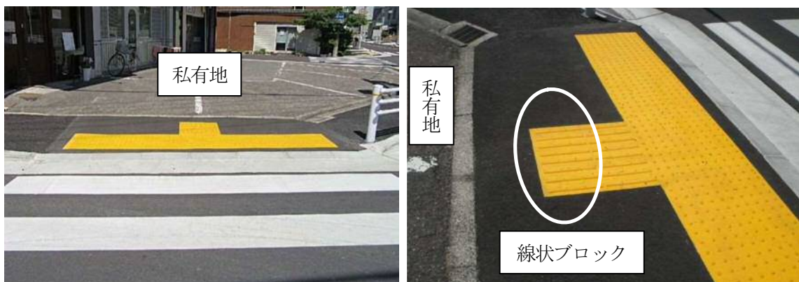
本件工事の状況
