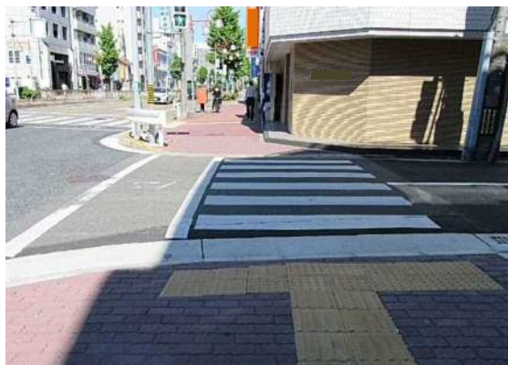
本件工事の状況
