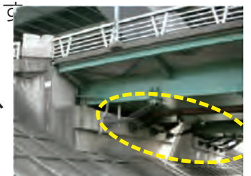
橋りょうの耐震補強の例
