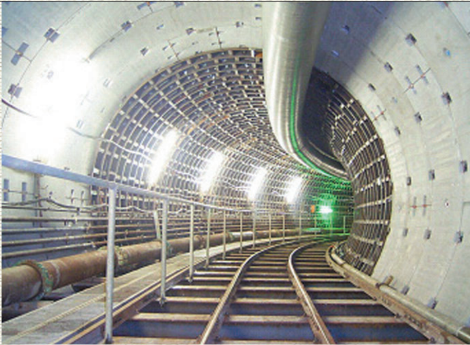
建設中の名駅南雨水調整池
