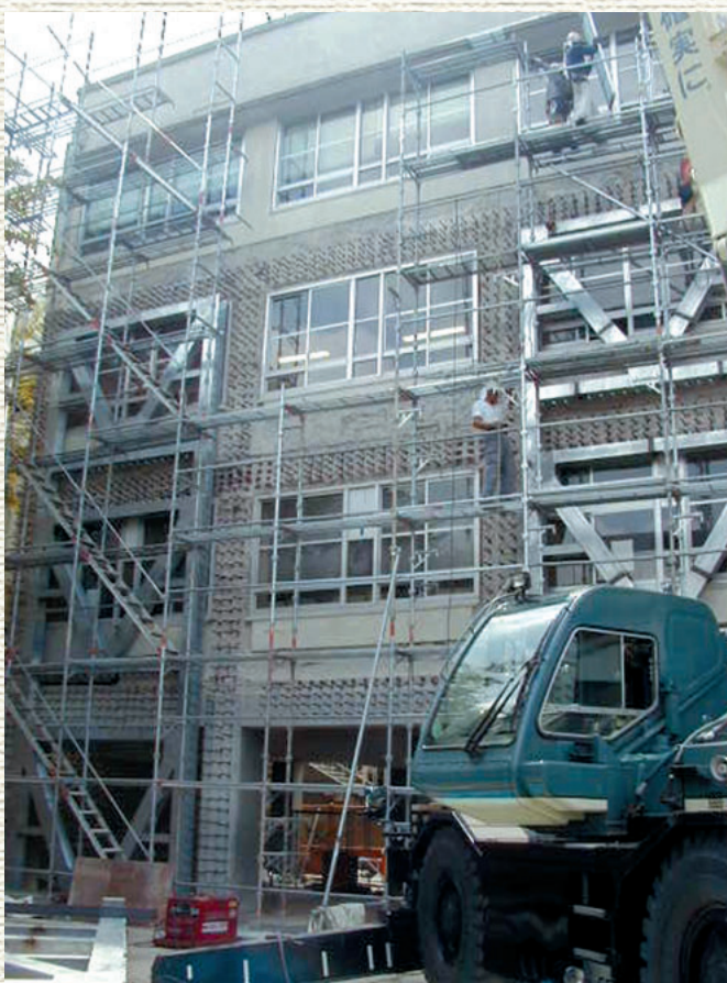
避難所(学校等)の耐震改修
