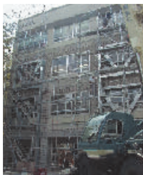
避難所(学校等)の耐震改修
