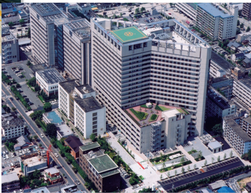
市立大学病院全景（病棟・中央診療棟）
