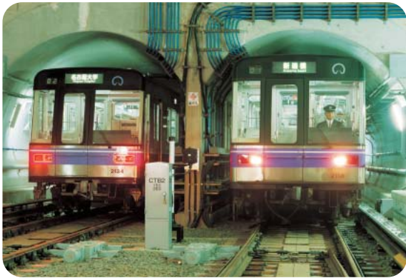
地下鉄4号線（名古屋大学駅付近）
