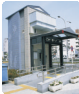
●地下鉄駅のエレベーター(名古屋港駅)
