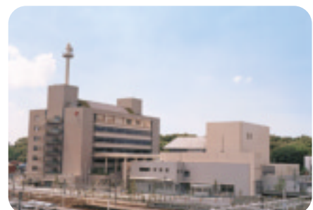
●熱田区役所等複合施設
