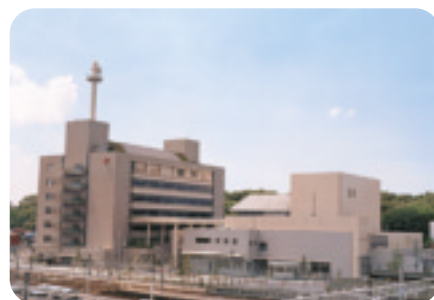
●熱田区役所等複合施設
