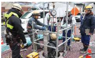
下水管の点検
