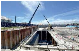
配水池を耐震化する工事
