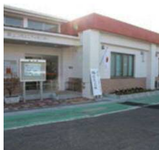
入り口もスロープを設け完全バリアフリー
