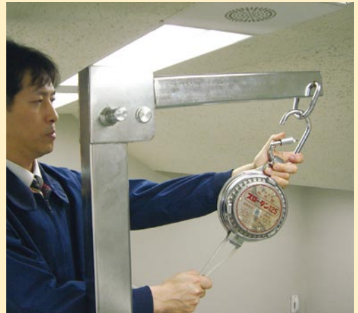
② 调速器の安全環を取付金具の吊環に掛け、止め金具を締め上げる
