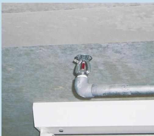
①天井に設置された感知ヘッドが熱を感知する
