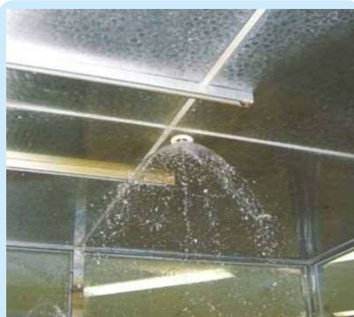
① スプリンクラーヘッドが熱を感知し、散水を開始する
