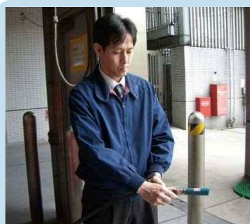
④ ホースを延ばしてノズルのバルブを全開にする
