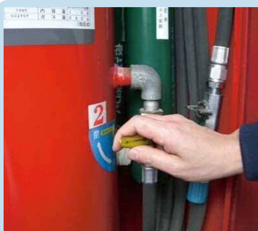
③ ホースの付け根にある放出弁を全開にする
