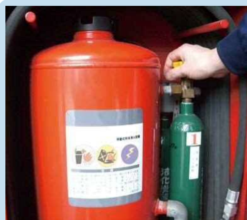
② 加圧用ガス容器のバルブを全開にする（反時計回り：左回転）
