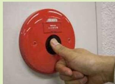
⑥ ポンプ起動ボタンを押し、赤色表示灯の点滅等で、ポンプ起動を確認する
