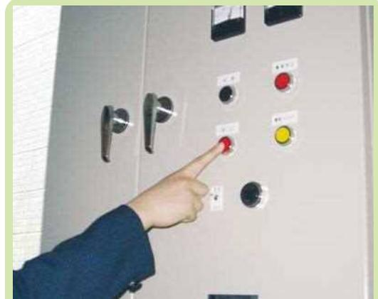
④ ポンプ制御盤(ポンプ室等)の停止操作を行う
