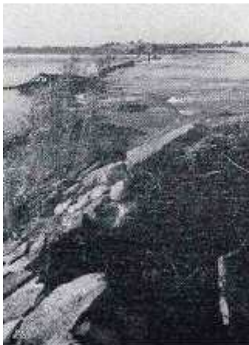
港区宝神町庄内川堤防決壊現場
