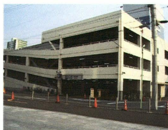
水害時に立体駐車場を一時的な避難場所として提供
